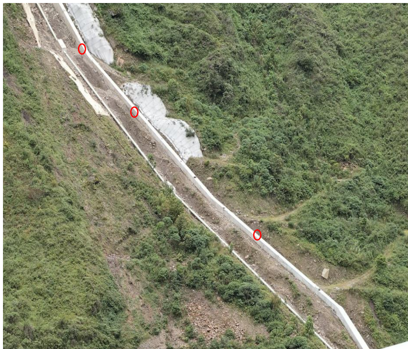
Fotografía N° 2. Orificios en los muros laterales del canal rápido de demasías
